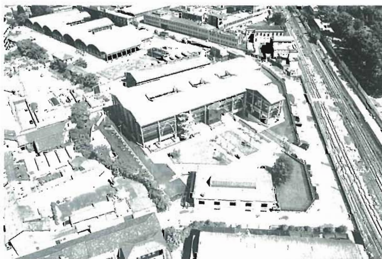
In alto, facoltà di Architettura in via Cosenz, edificio ex Lepetit; in basso, facoltà di Ingegneria in via La Masa, edificio ex FBM ed ex IVI PPG.
