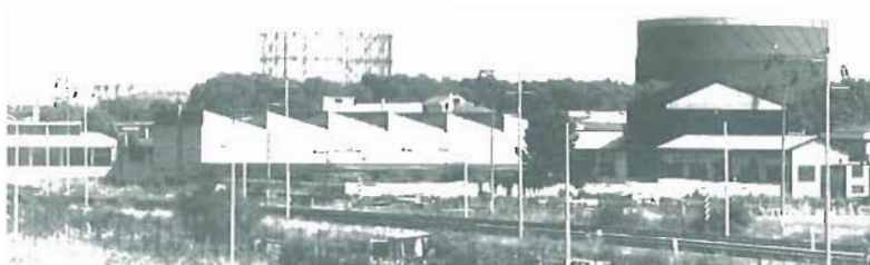
Sopra, i gasometri a Bovisa; nella pagina a fianco, fotopiano dell'area Bovisa.
