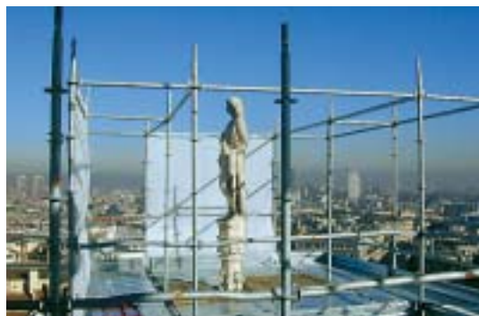
1. Duomo di Milano. Intervento conservativo attualmente in corso (2004); parte terminale del ponteggio intorno ad una guglia Cathedral of Milan. Conservation work in progress (2004); final part of the scaffold around a spire
