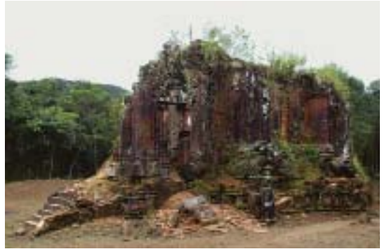
3. Kalan G1 per il quale è previ- sto il progetto di restauro Kalan G1 for which a restau- ration project has been prepa- red by Politecnico
